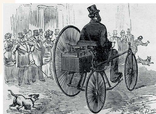
Fig. 13 : Tricycle électrique de Trouvé (Alain Clément, Physique et chimie populaires , vol. 2, 1881-1883)
